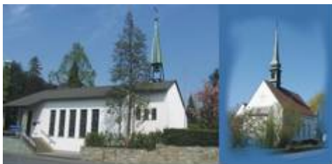
Martin Luther Kirche, Geseke (errichtet 1933, erweitert 1963)
