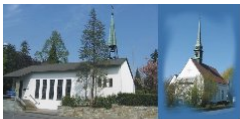
Martin Luther Kirche, Geseke (errichtet 1933, erweitert 1964)
